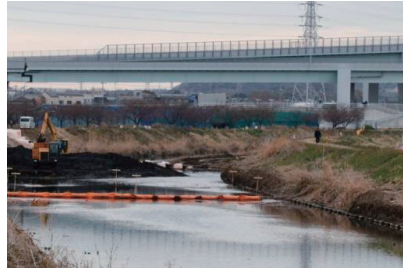
図 4 西久保橋-萩園橋間 (No. 2) (2019. 2/13, 浚渫工事中)
