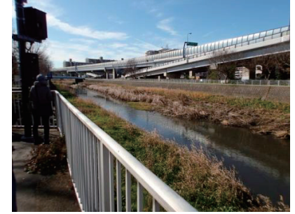
図 8 中原橋-下町屋橋間 (No. 6) (2020. 1/10)
