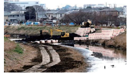
図 5 西久保橋-萩園橋間 (No. 2) (2019. 2/13, 浚渫工事中)
